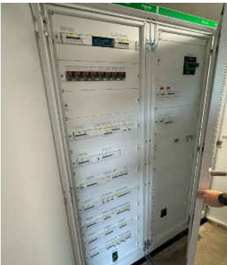
Remplacement du TGBT
